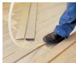
Alu-plader og slanger monteres let i thermogulvet
