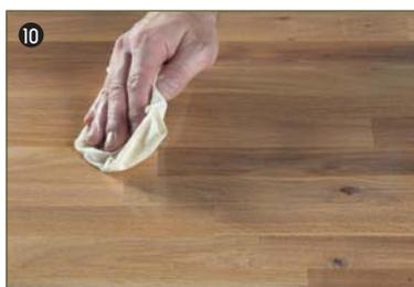
Efter ca. 15 minutter aftørres overskydende olie. Afsluttende aftørres pladen med en tør klud.
