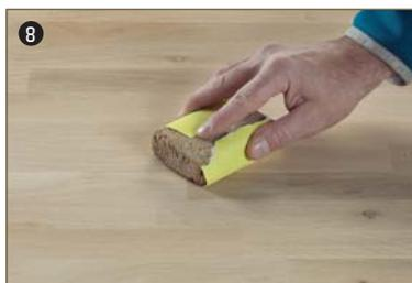
Bordpladen afslibes med fint sandpapir til overfladen er glat og ensartet. Der anvendes slibepapir korn 180.
