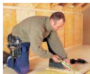
Pladerne skrues og limes til stræerne med stre-afstand op til 30 cm
